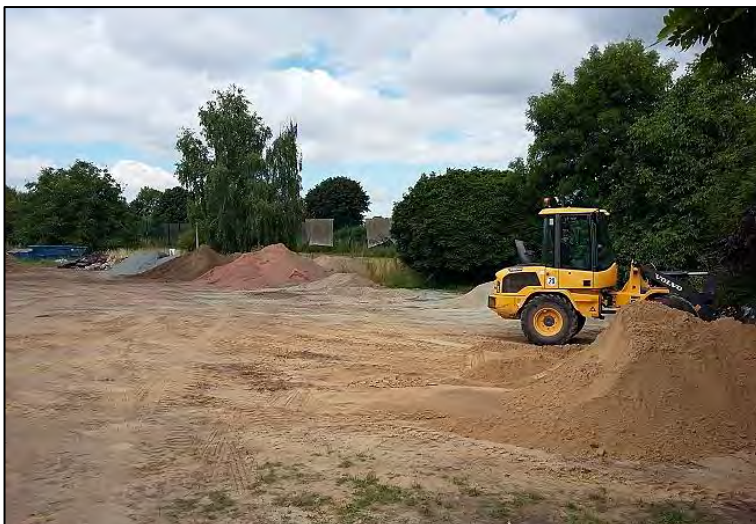
Baustofflagerplatz im zentralen Bereich
