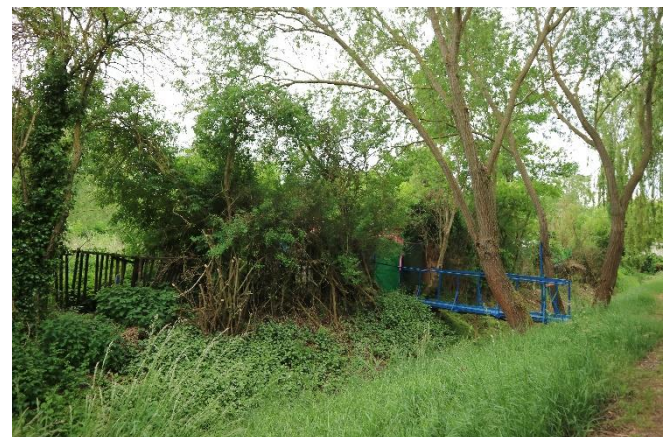
4 Weiterer Zugang über eine Brücke
