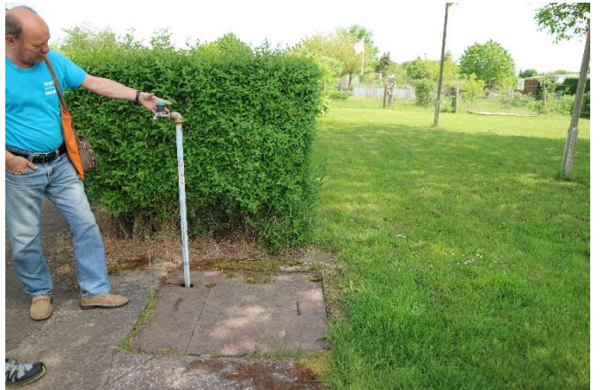
4 Ehemalige Wasserversorgung durch Sophienquelle, heute nicht mehr intakt
