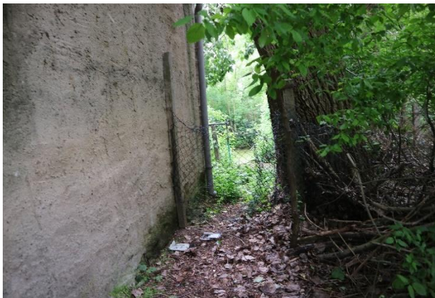
21 Derzeitige Situation am Tümpel, Sicherung und Einbau einer Tür angedacht
