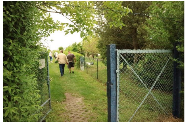
8 Südöstlicher Eingangsbereich, derzeit mit Stacheldraht, zu entfernen
