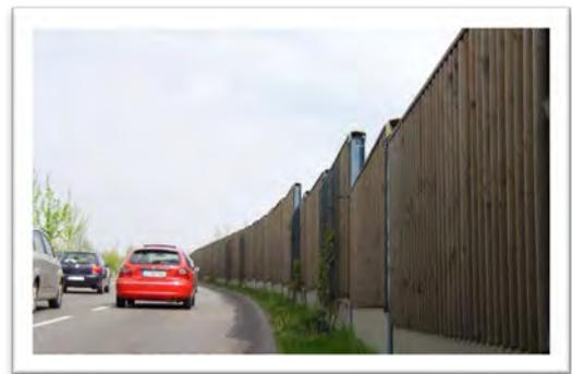
Es lassen sich durch Lärmschutzwände hohe Abschirmungen bis zu 20 dB(A) erzielen. Voraussetzung ist jedoch, dass die Sichtverbindung zwischen Quelle (Fahrstreifen) und Immissionsort (Fassade/Fenster) unterbrochen ist. Das Bild 12 stellt die Schallpegelminderung durch Schallschutzwände dar.
