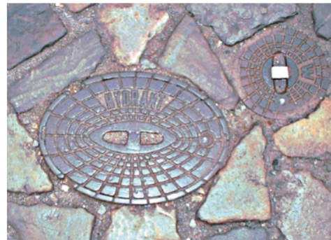
Unterflurhydrant (ovaler Deckel mit Aufschrift Hydrant )
