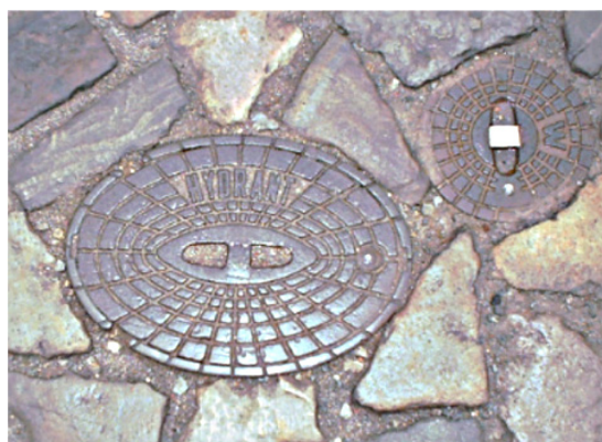
Unterflurhydrant (ovaler Deckel mit Aufschrift Hydrant )
