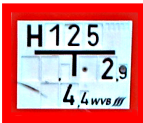
Hinweisschilder zum Auffinden von Hydranten
