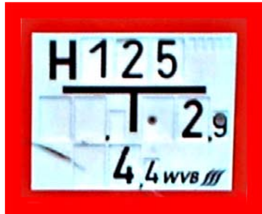
Hinweisschilder zum Auffinden von Hydranten
