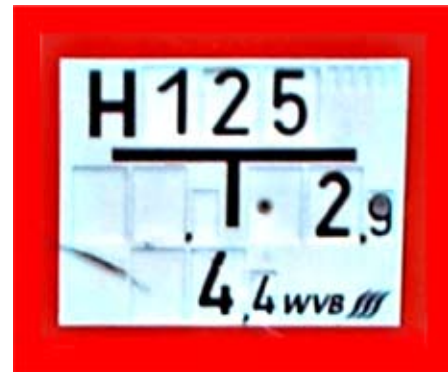
Hinweisschilder zum Auffinden von Hydranten
