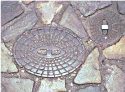
Unterflurhydrant (ovaler Deckel mit Aufschrift Hydrant )
