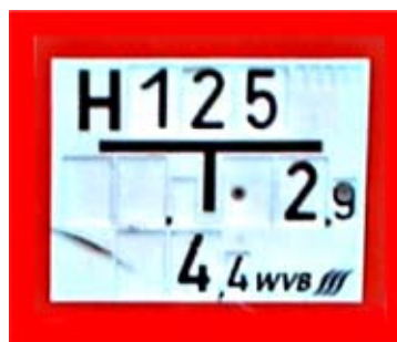
Hinweisschilder zum Auffinden von Hydranten
