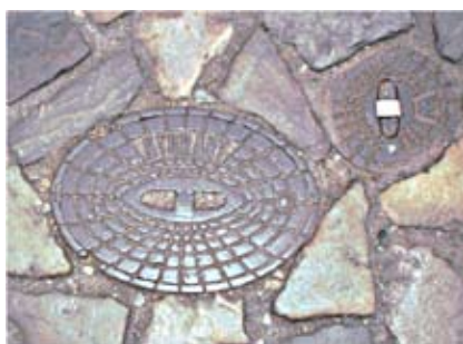
Unterflurhydrant (ovaler Deckel mit Aufschrift Hydrant )
