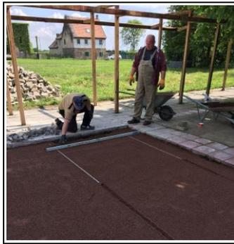
Der Unterbau Kiesbett und Splittschicht sind eingebracht
