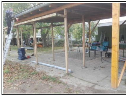
September / Oktober 2017 Bau einer überdachten Terrasse von 85 m 2 für Freizeit und Training bei Regen Foto: W. Pflanz
