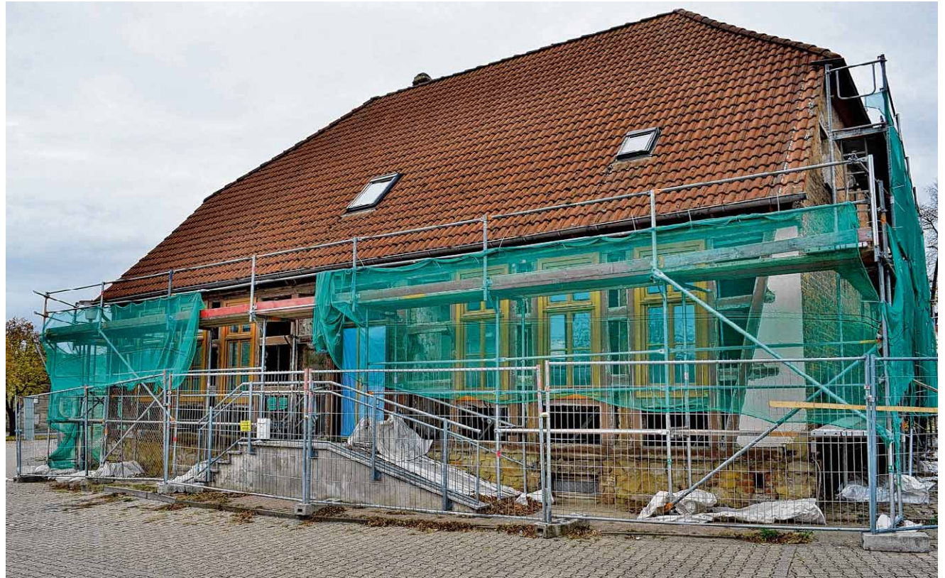
Die Bauarbeiten in der Remkersleber Kindertagesstätte „Zwergenland“ ruhen seit Monaten. Im Dezember sollen sie fortgesetzt werden. Das unter Denkmalschutz stehende Haus wird energetisch saniert.
