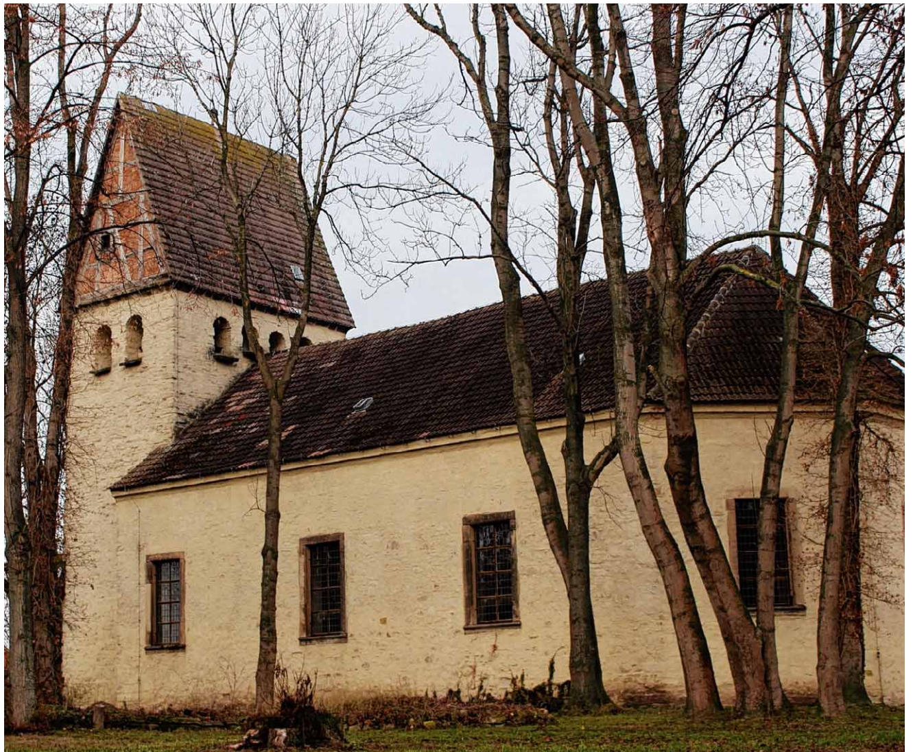
Wie schlimm es um die Klein Rodensleber Pankratius-Kirche und speziell um das Dach des Kirchenschiffes steht, hat lange Zeit niemand geahnt. Jetzt ist die Kirche erst einmal gesperrt.
