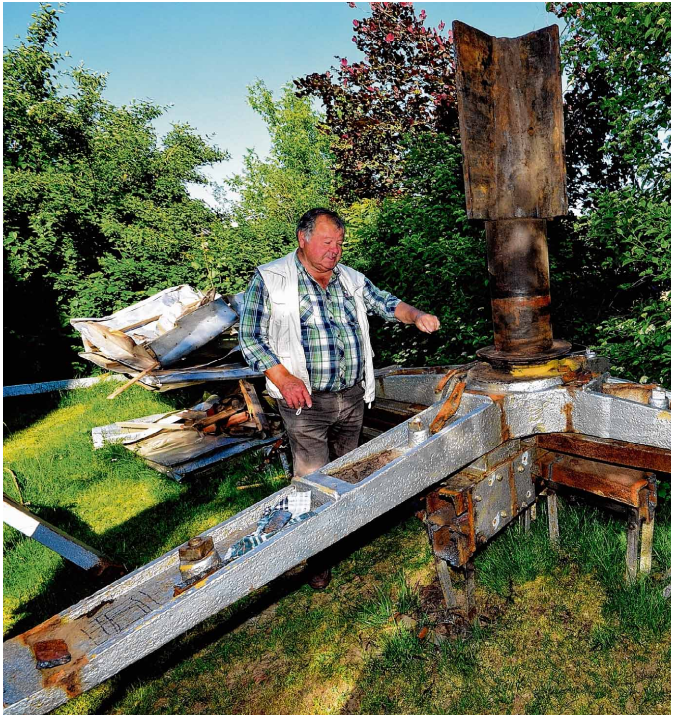
Der Orkan „Friederike“ hat im April 2017 große Teile der Windmühle in Klein Gemersleben zerstört. Die in Magdeburg wohnenden Mühlenbesitzer Erika und Siegfried Graumann machten sich daran, das unter Schutz stehende Baudenkmal wieder herzurichten. 2019 will Leader den Wiederaufbau des Flügelkreuzes fördern.
