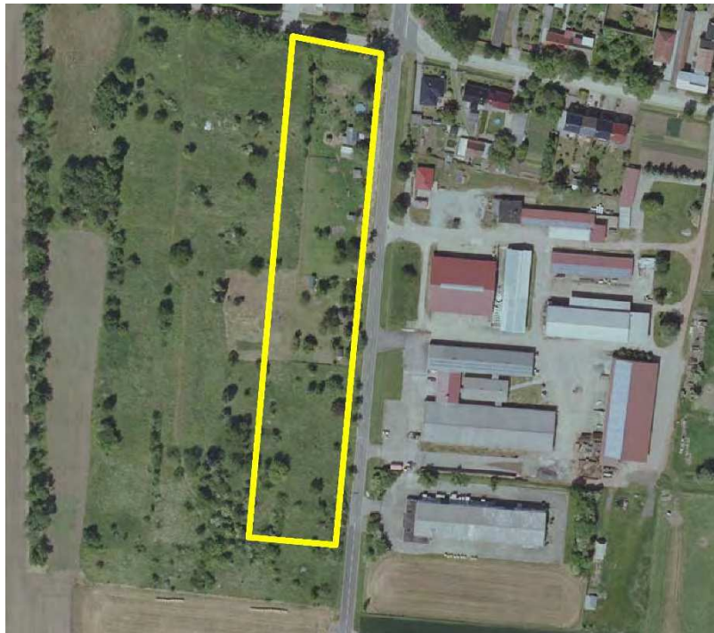
Luftbild des Bereiches der geplanten gemischten Baufläche auf Teilflächen der ehemaligen Kleingartenanlage Klein Germerslebener Straße
