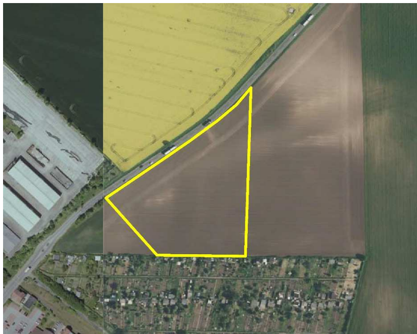
Luftbild Ortseingang Wanzleben aus Richtung Schleibnitz
